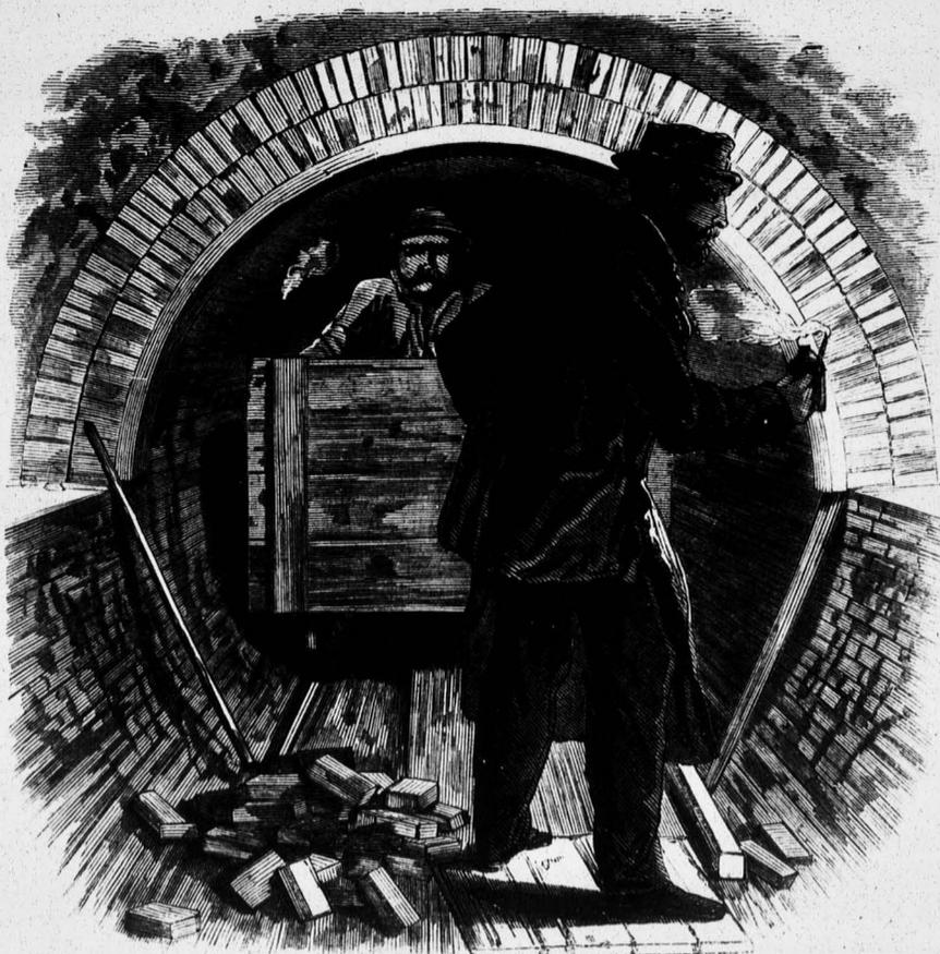
WORKMEN CONSTRUCTING THE UPPER ARCH OF THE TUNNEL.
